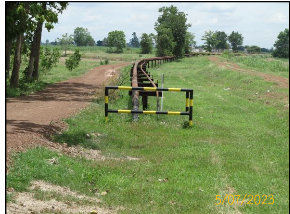
ภาพที่ 2.3-6 การติดตั้งรั้วกันชนแนวทอ
