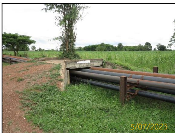
ภาพที่ 2.2-5 ทางข้ามแนวท่อ (Pipe Crossing)
