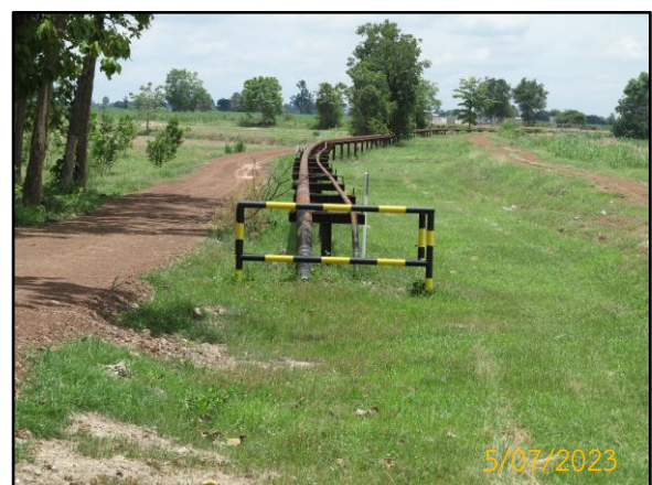
ภาพที่ 2.2-6 การติดตั้งรั้วกันชนแนวท่อ
